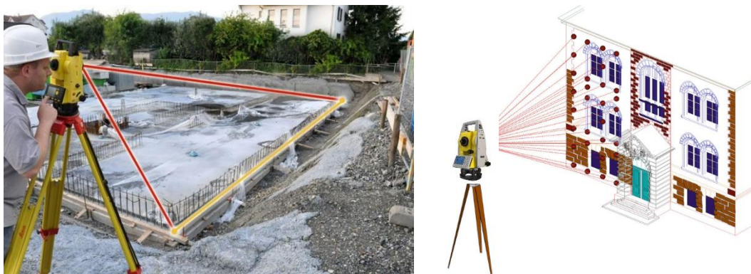
Slika4. Izvođenje tahimetrom i pregledom po mjeri
